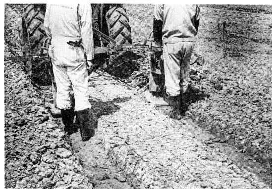
図3 トラムラインの仕上げ作業状況
